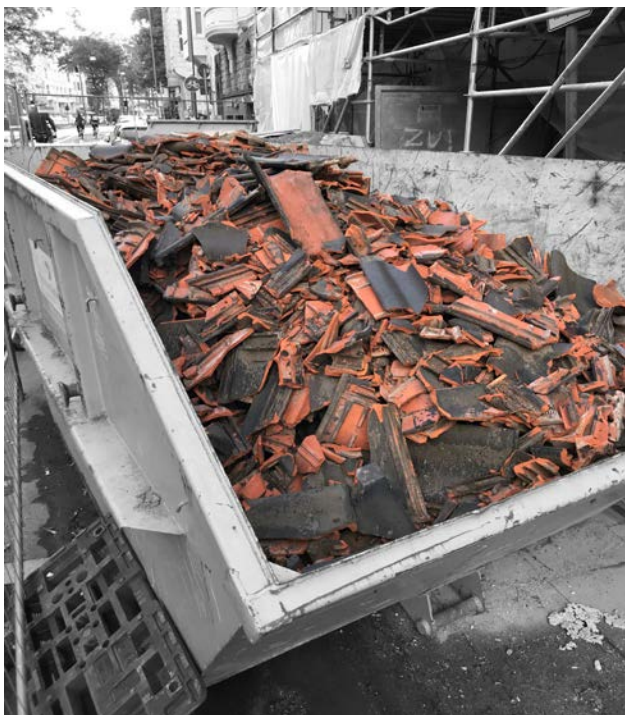
Intakte Dachpfannen enden in der Ressourcenvernichtung
