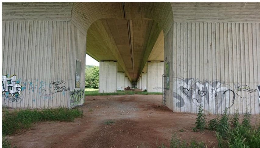
A66 Talbrücke bei Bad Soden Landwirtschaftliche Nutzung unter der Brücke
